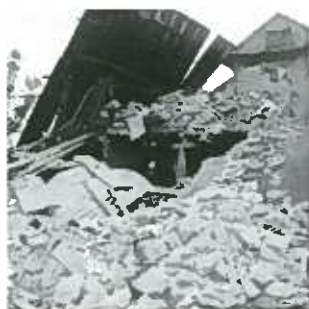
ネパール大地震での被害の様子
